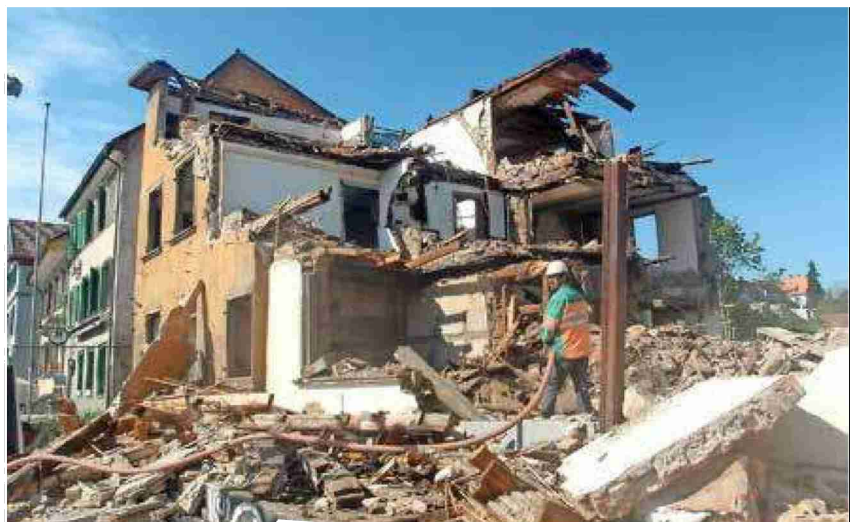
Zügig gingen der Abbruch des «dolder2» und der Neubau der Mehrfamilienhäuser voran, nachdem der Heimatschutz seinen Rekurs Ende 2016 zurückgezogen hatte. ARCHIVBILD ZVG
