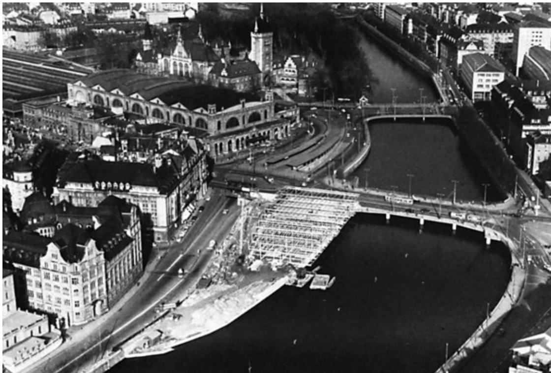
Das Globusprovisorium im Bau, 1960. (Foto: Stahlbau-Bericht)
