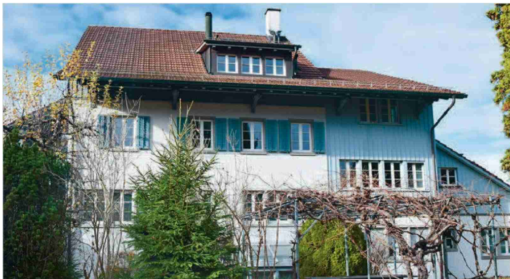
Aus Gründen des Ortsbildschutzes und nicht wegen der Denkmalpflege historisierend neu gebaut: Haus in Maur.
