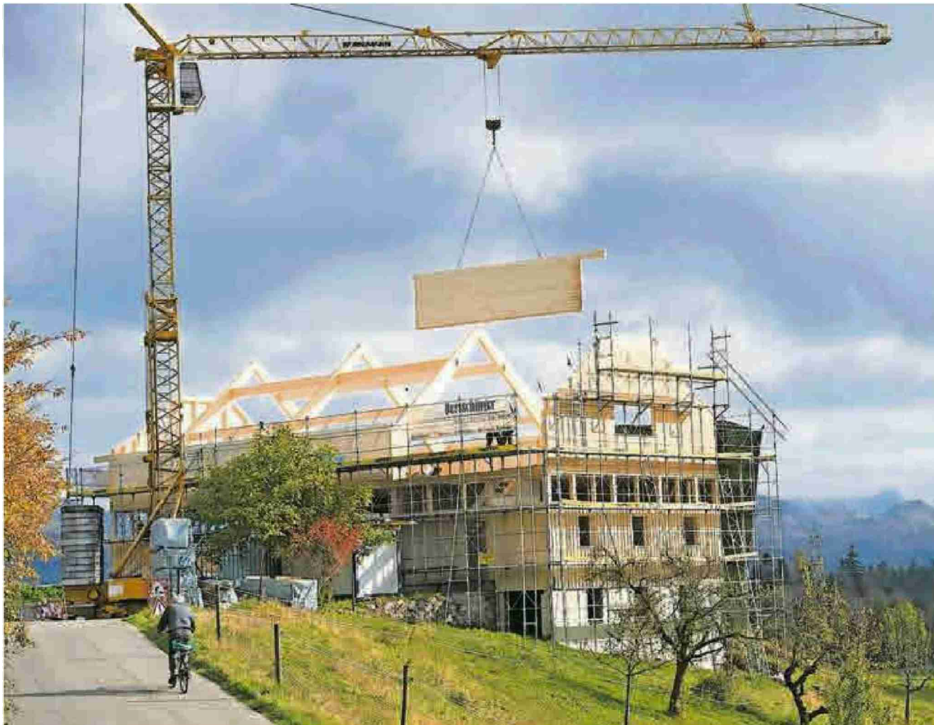
Beim Wiederaufbau der alten Ziegelbrennerei wird den heutigen Nutzungsbedürfnissen Rechnung getragen.
