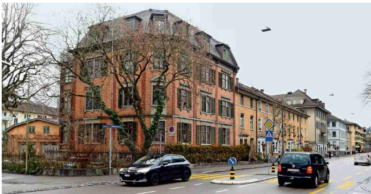
Die Wohnungen im Haus an der Salstrasse 20 sind fast noch im Originalzustand erhalten. Sie dokumentieren die Wohnsituation des höheren Sulzer-Kaders am Ende des 19. Jahrhunderts. Aichli / mod
