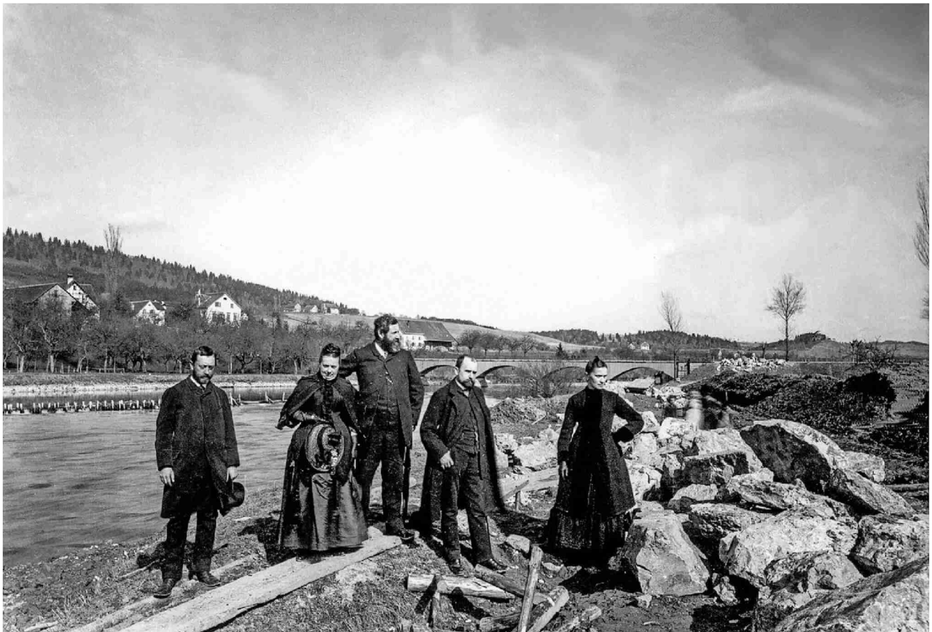
Kantonsingenieur Kaspar Welti inspiziert die Baustelle der Limmatkorrektur. Bild um 1890.
